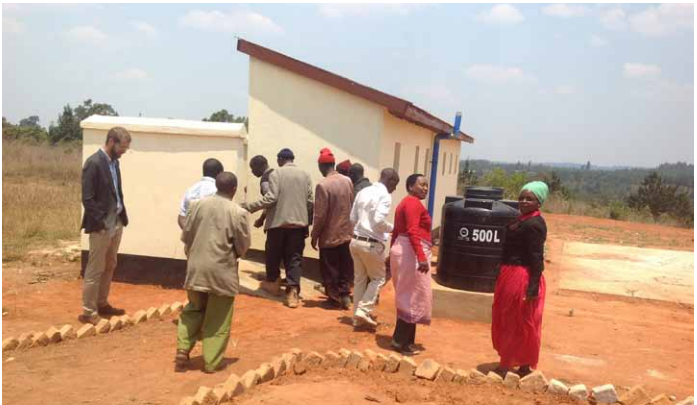
Pamoja na kujenga vyoo wataalamu wa Halmashauri hupita kukagua kama ujenzi umekidhi viwango vilivyowekwa na Serikali. Wataalamu wa Halmashauri wakiwa katika ukaguzi wa vyoo vilivyojengwa katika shule ya Msingi Lole Ikuna katika Halmashauri ya Wilaya ya Njombe.
