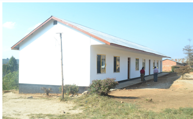
moja ya Mradi wa ujenzi wa vyumba viwili vya madarasa katika shule ya Sekondari Mulunga Iliyopo katika Kata ya Ukalawa Halmashauri ya wilaya ya Njombe ambao ujenzi wake umekamilika.
