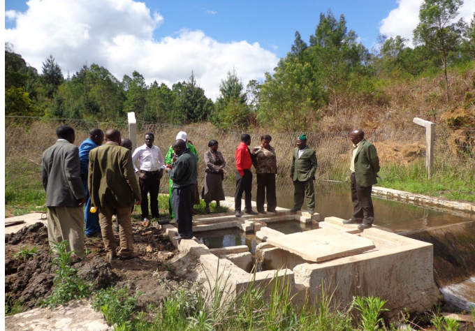
Wajumbe wa kamati ya Fedha, Uongozi na Mipango wakiwa na wataalamu wa Halmashauri ya Wilaya wakikagua chanzo cha maji kijiji cha Image
