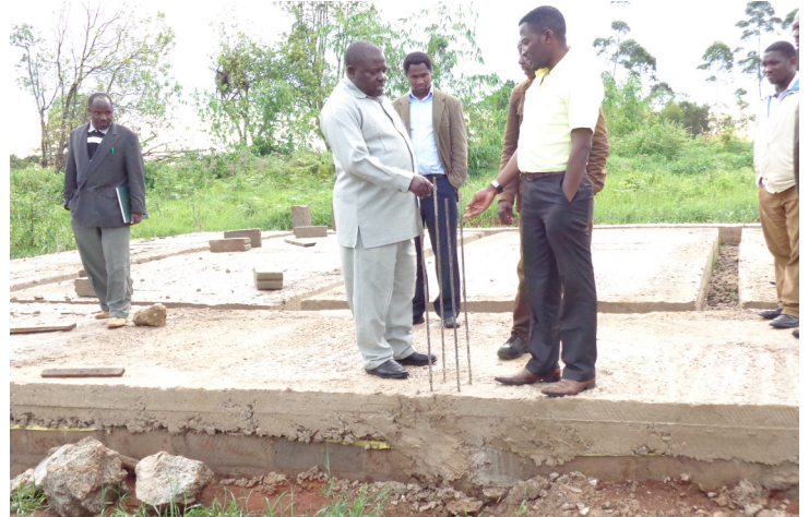
Mkurugenzi Mtendaji Halmashauri ya wilaya ya Njombe Bw Paulo Malala akikagua ujenzi wa maabara katika shule ya sekondari Lupembe
