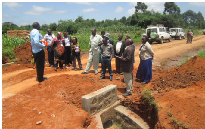
Mhandisi wa Ujenzi Halmashauri ya wilaya ya Njombe Bw. Samson Kalesi (kushoto) akitoa maelezo juu ya ujenzi wa barabara ya Ninga-Kichiwa kwa madiwani wa Halmashauri ya Wilaya wakati wa ukaguzi wa miradi ya maendeleo.
